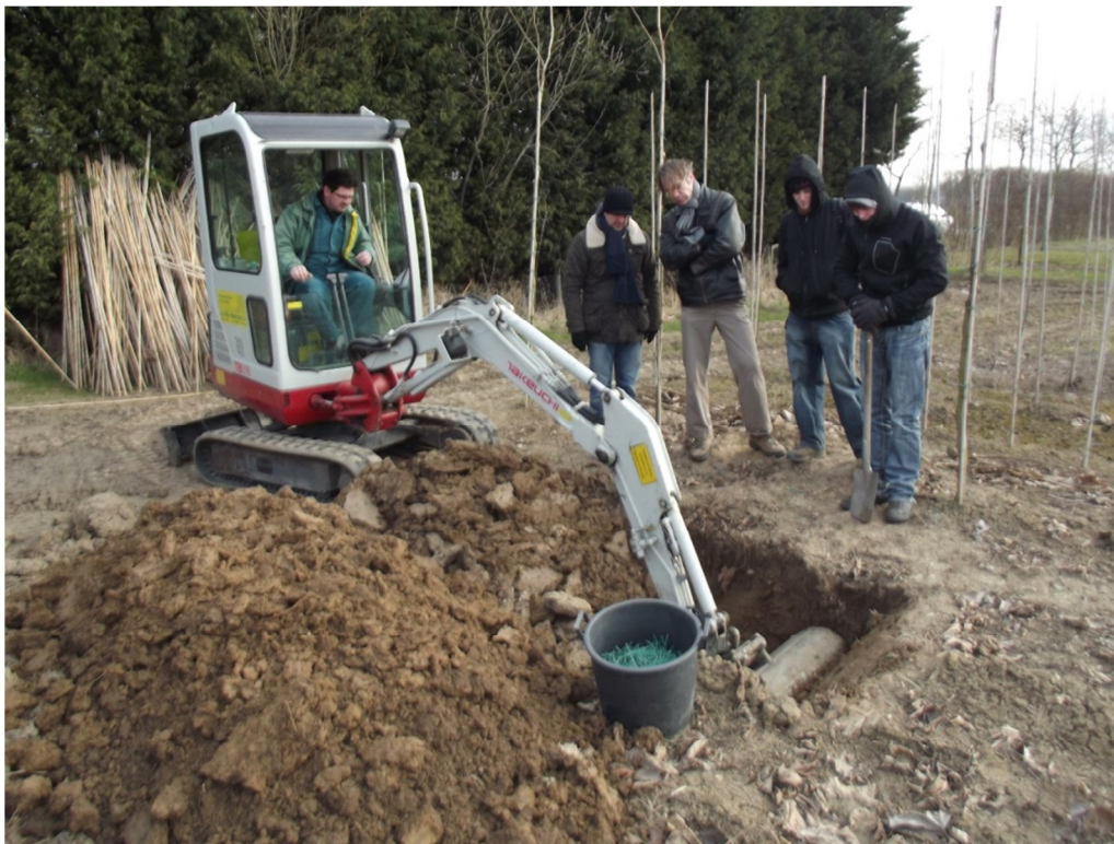
Het onderzoek werd uitgevoerd met de inzet van een mini-graafmachine. Hier wordt de eerste put op perceel 1 gegraven met een bak van 100 cm. De overige putten zijn gegraven met een bak van 30 cm.
